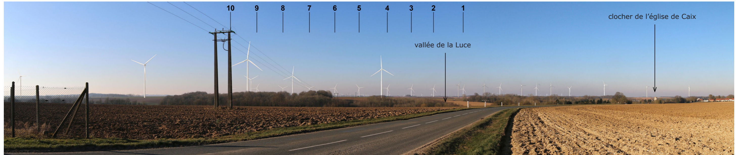
VARIANTE 3 et 4 - vue panoramique depuis la D28 vers l'entrée est de Caix - 9 MACHINES / 150 m EN BOUT DE PALE / 3.3MW et 3.45MW
